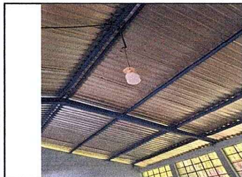
Foto 3: Mantenimiento de estructura soporte de metal (oxidación) para mayor vida útil (lijado y pintado).
