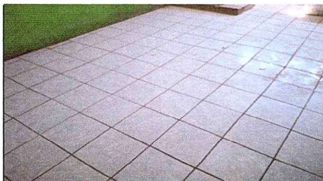
Foto 10: Instalación de piso ceramico para mejorar las condiciones de la cocina.
