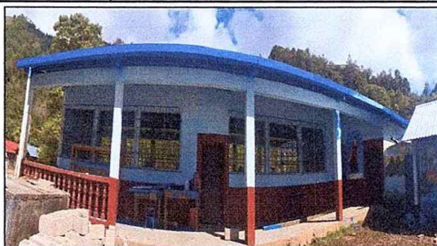
Foto 8: Instalación de canales metalicos con sus respectivos pescantes para mejorar la captacion de aguas pluviales.
